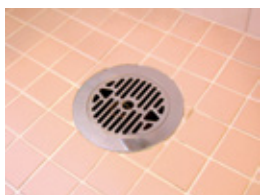
床上排水口タイプ (排水口が床と同じ高さ)
