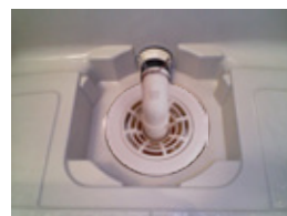
排水パイプが貫通
